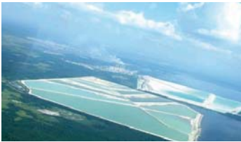
Abwasserneutralisation mit Kohlendioxid.
