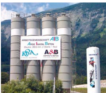
Stickstoff wird zum Zementkühlen eingesetzt.
