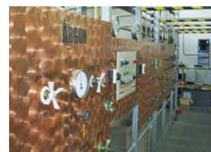
Neue Abfüllstellen machen den Standort Police leistungsfähiger.
