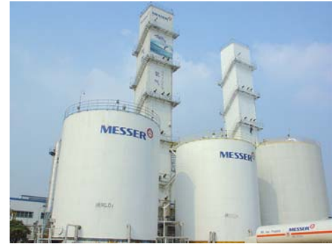
In Foshan wurde eine zweite Luftzerlegungsanlage eingeweiht.
