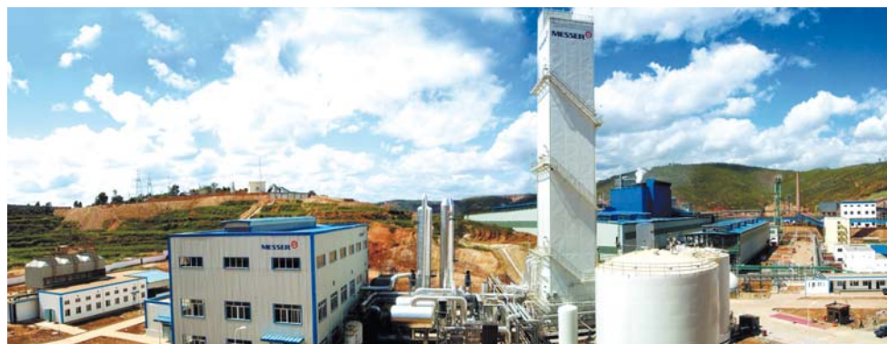
Die Luftzerlegungsanlage in Yuxi gilt als eine der „schönsten“ in der Messer Welt.
