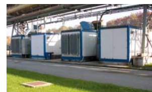
Membrananlage – N 2 -Lieferungen für On Site-Kunden OKD, DPB.
