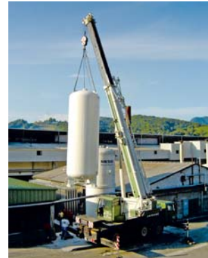
Einen neuen Sauerstofftank installierte Messer Croatia Plin bei Vetropack.
